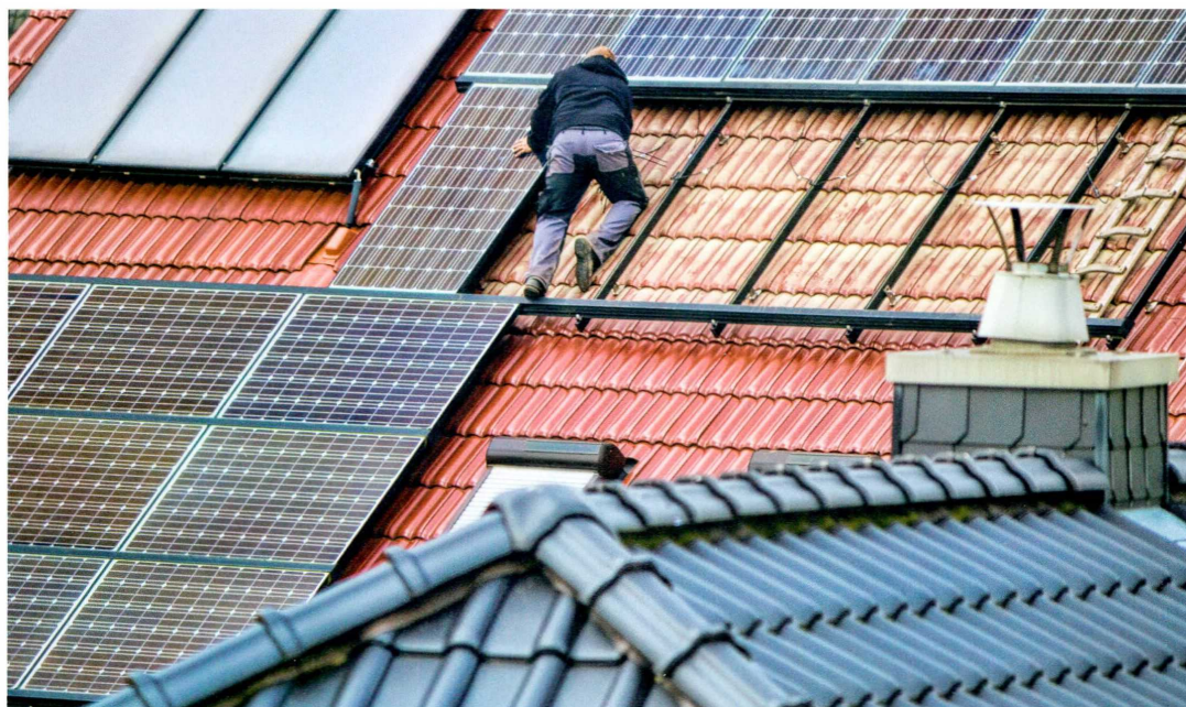
Montage von Solarmodulen auf einem Steildach.
